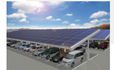
カーポート型太陽光発電施設
